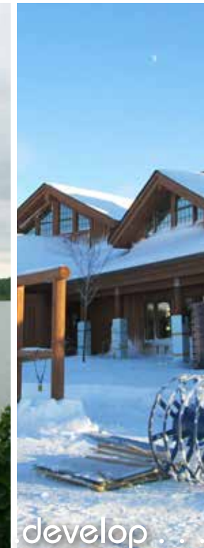
Tettegouche Visitor Center
